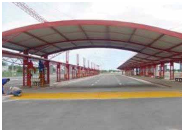
Figura 16 – Piso Tátil, Rampas e “Travessia Elevada”
