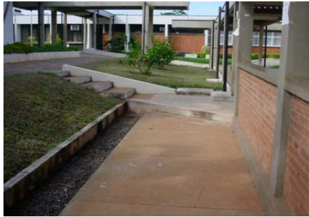
Figura 2. Grades em canaletas pluviais.
